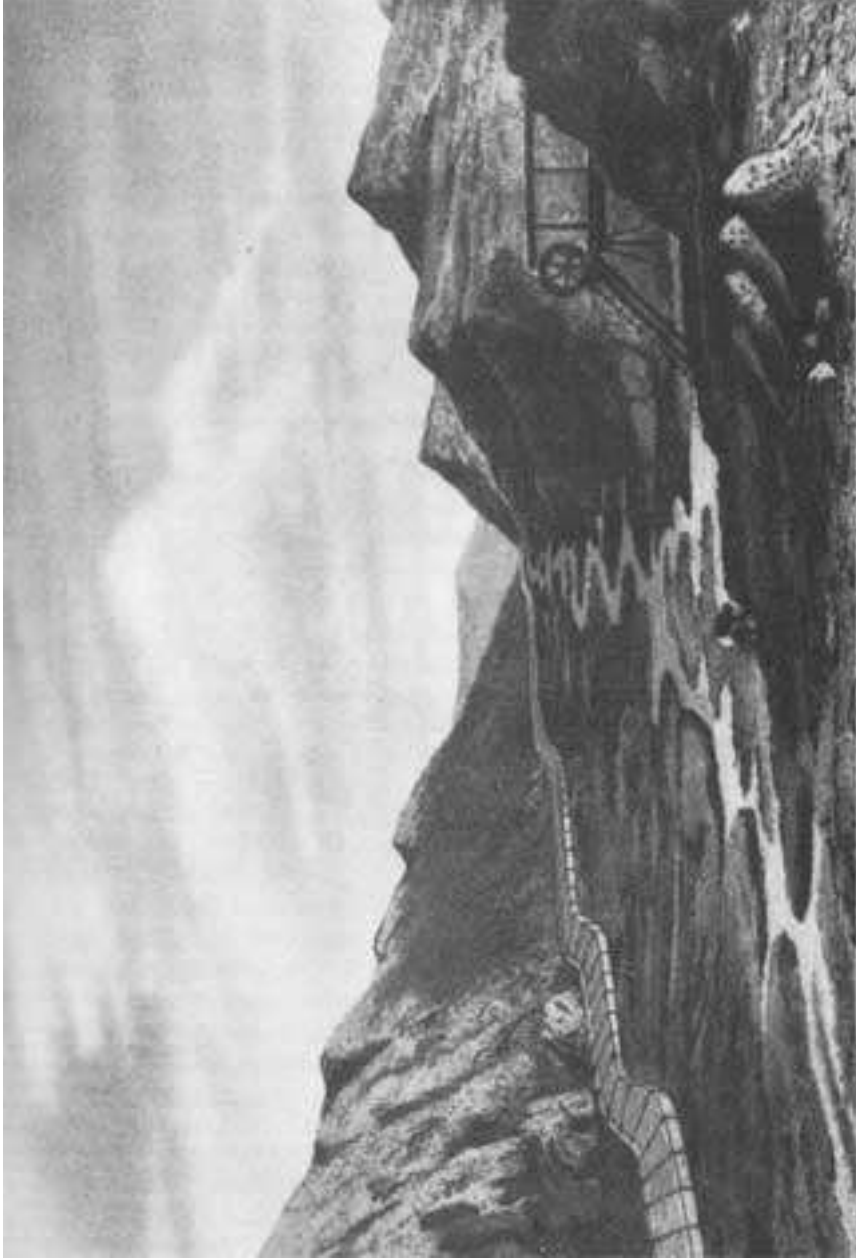
Vista mostrando o modo pelo qual foi posta a seco uma parte do Rio Jequimbonha, para facilitar a lavra dos diamantes. (John Mawe)
