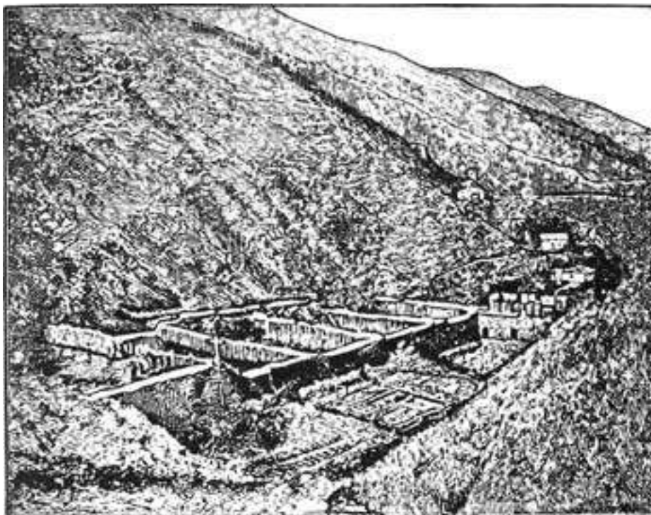
Mondéu do Veloso, em Ouro Preto. Grande reservatório para receber a lama aurífera, arrastada pela ação hidráulica em terras mineralizadas a montante. (Paul Ferrand)
